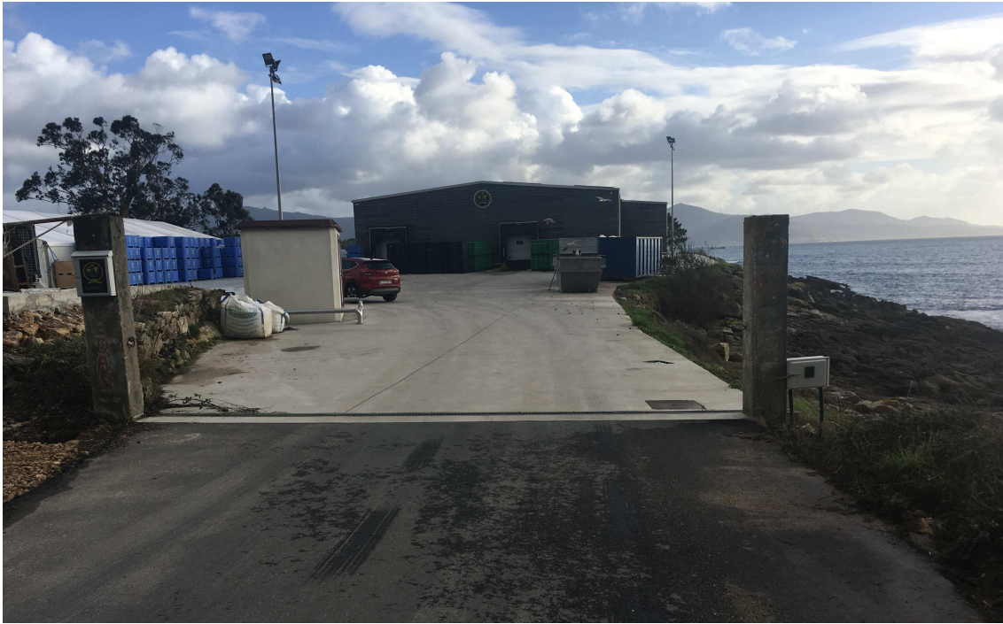
Entrada a la propiedad de la depuradora de Mariscos Antón S.L.U.
