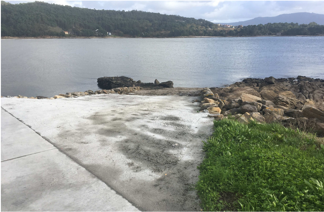
Rampa y muelle existentes situados en el extremo sur de la propiedad
