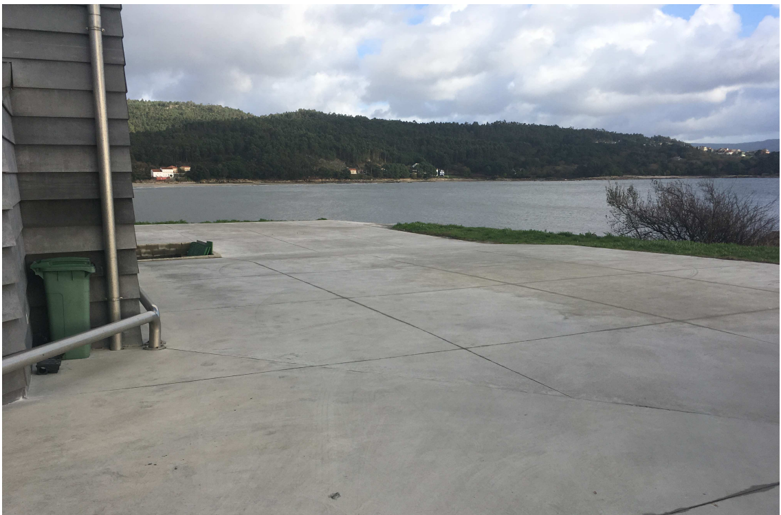
Extremo sur de la propiedad de la depuradora de Mariscos Antón S.L.U.
