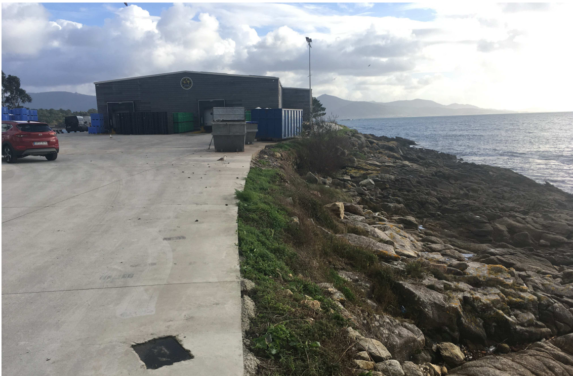
Extremo oeste de la propiedad de la depuradora de Mariscos Antón S.L.U.
