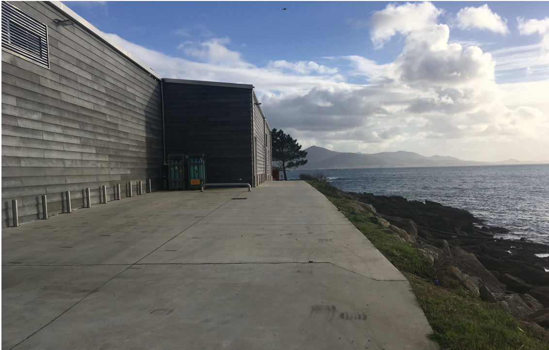
Extremo oeste de la propiedad de la depuradora de Mariscos Antón S.L.U.
