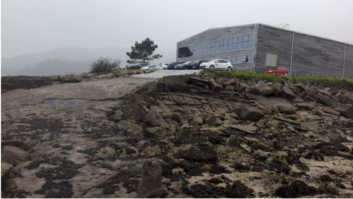
Vista de la depuradora desde el muelle situado en el extremo sur de la propiedad
