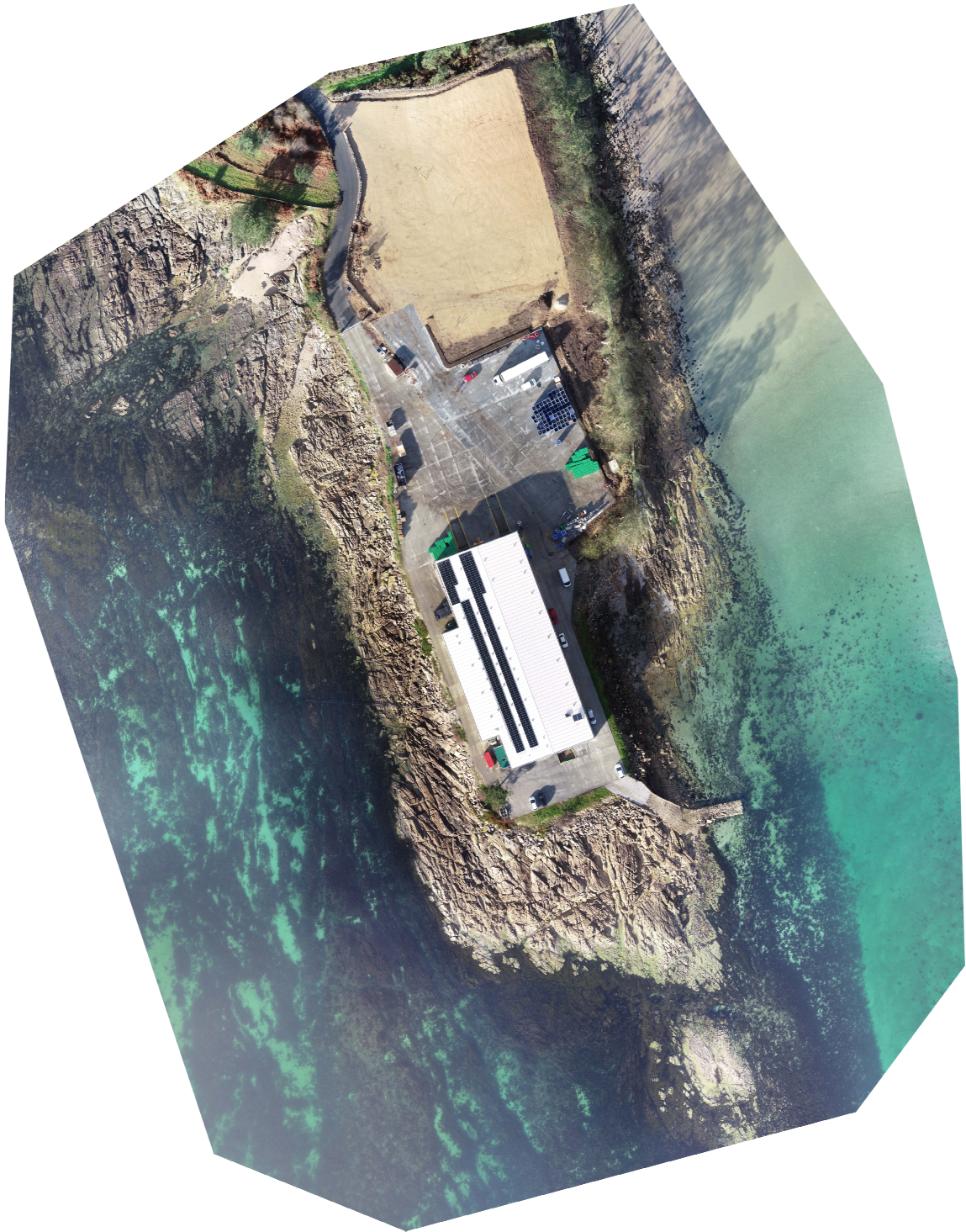
Vista general de la propiedad de la depuradora de Mariscos Antón S.L.U.
