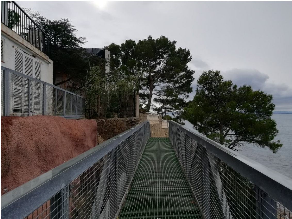
Fotografia 4. Passarel.la existent d'estructura metàl.lica galvanitzada
