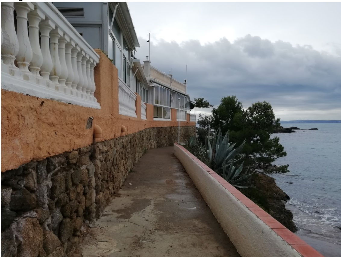
Fotografia 6. Tram camí amb paviment de formigó
