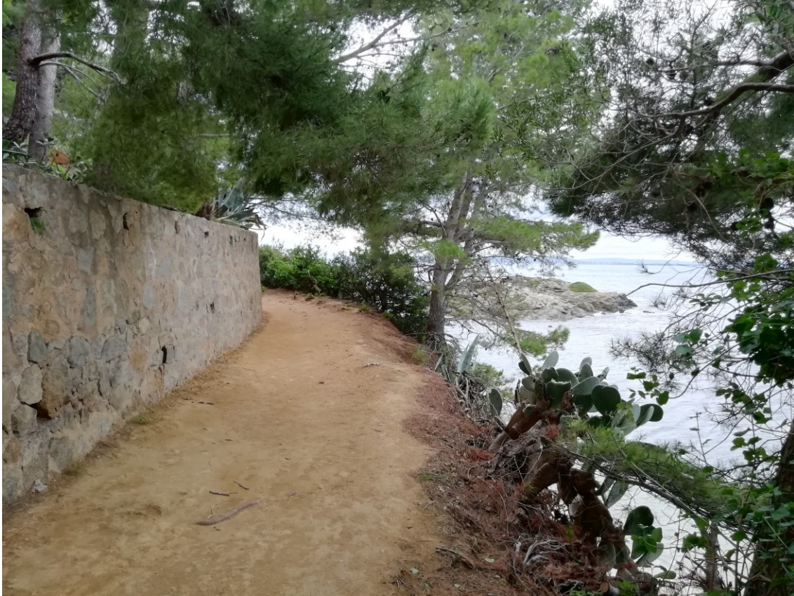
Fotografia 7. Tram camí amb paviment de terra
