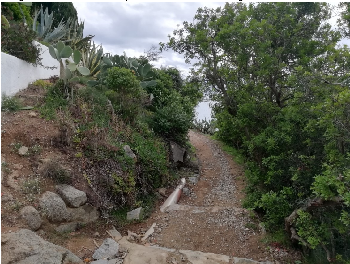
Fotografia 12. Tram camí amb presència de xarxa de clavegueram i graonat
