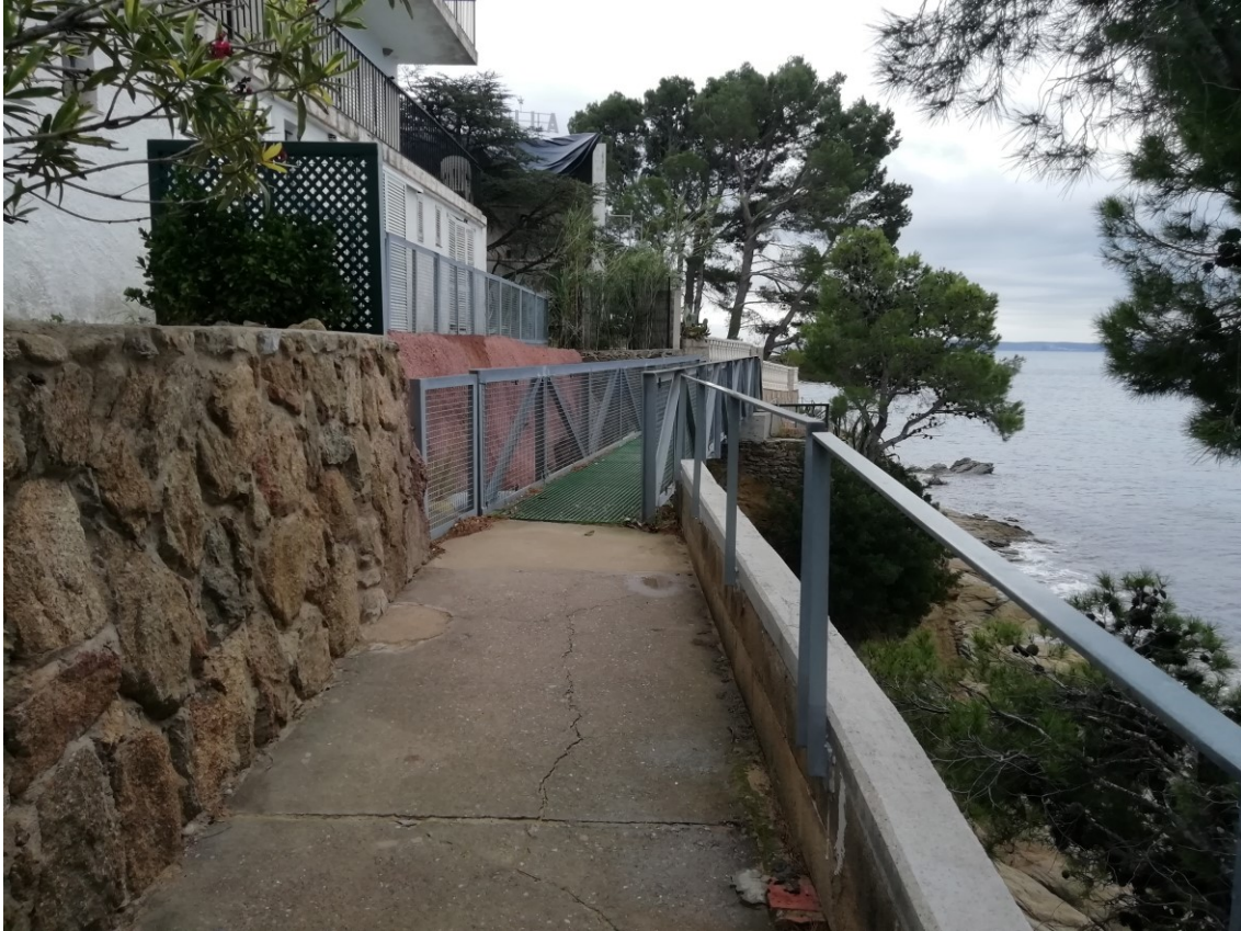
Fotografia 3. Inici Passarel.la existent d'estructura metàl.lica galvanitzada
