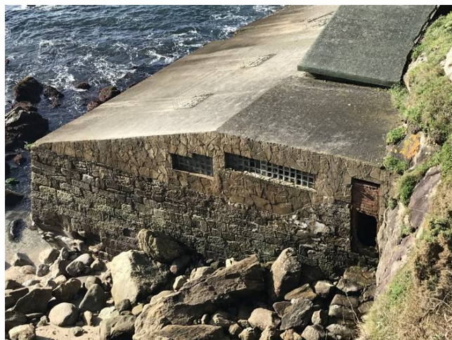
Ilustración 6: Vista cara Este de la instalación
