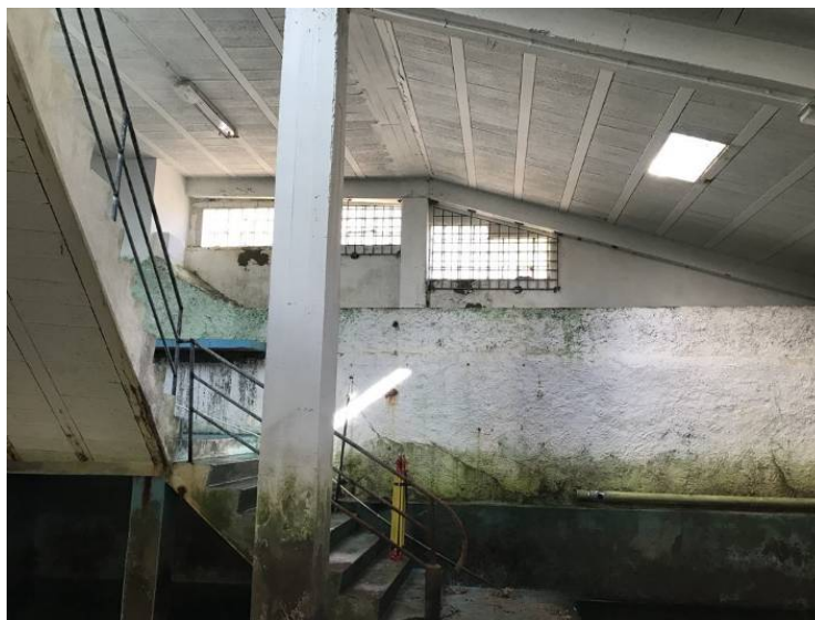
Ilustración 5: Vista desde el interior de la cubierta y escaleras de acceso.
