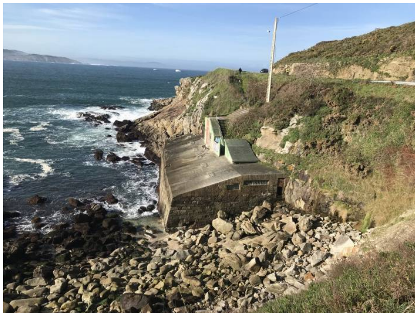
Ilustración 3: Vista general de la instalación
