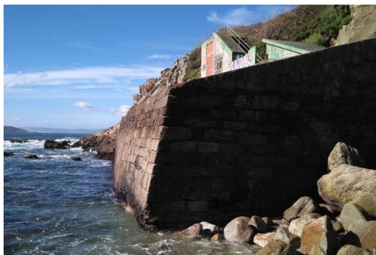
Ilustración 4: Muros de carga
