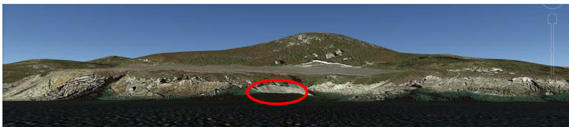
Ilustración 10: Integración de la instalación en el entorno de Monte Carboneiro
