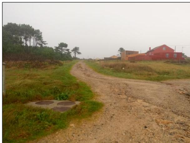
► **TRAMO 2:** tiene una longitud de 106,00 m. con ancho de calzada de 4,00 metros, actualmente se encuentra pavimentado con piedra y zahorra
