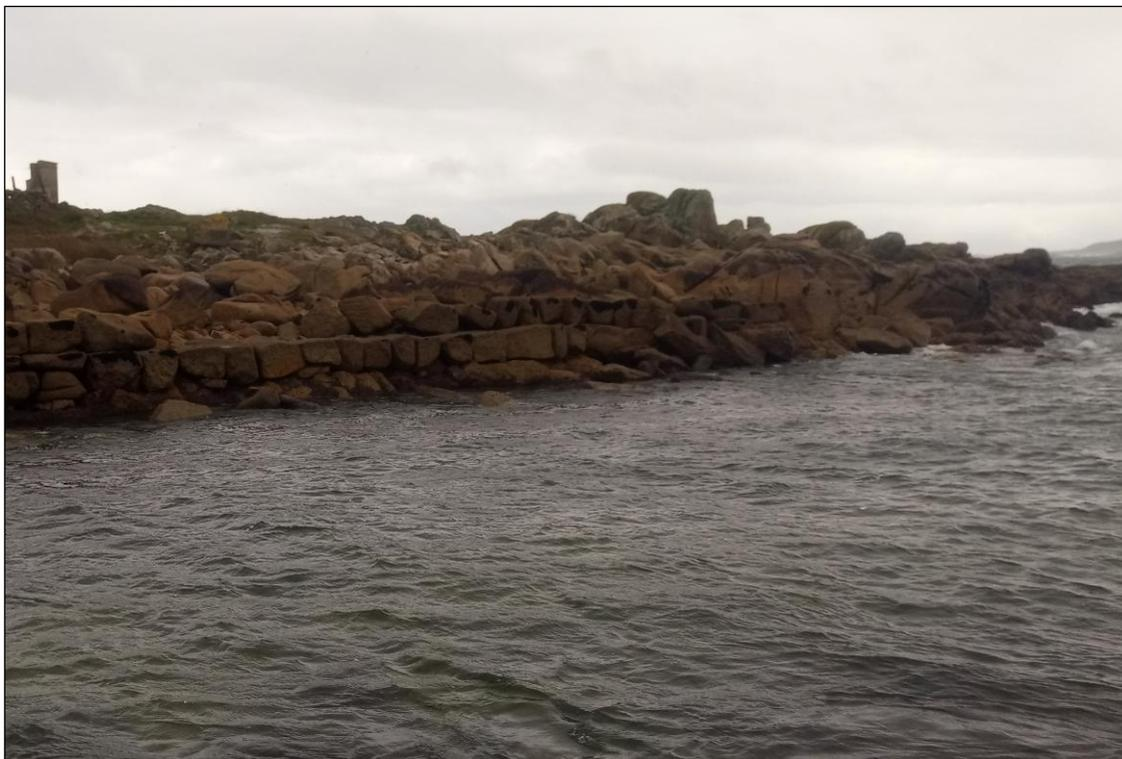
Como en el resto del muelle, una vez retiradas las piedras mal colocadas o en mal estado, procederemos a elegir oiedras del acopio o de cantera para ir completando las hileras que faltan hasta conseguir el estado definitivo.
