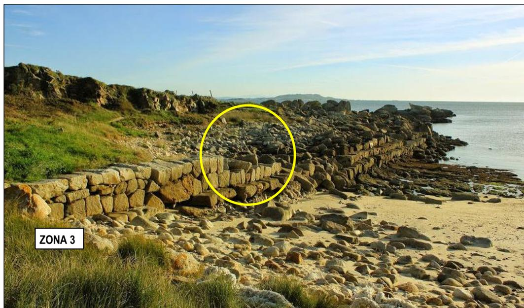
La Zona 3 se encuentra en una zona de transición entre una zona en buen estado y otra totalmente derrumbada. En esta zona vemos claramente las tres primeras hileras en buen estado pero la ausencia total de piedras en la superior o de coronación.
