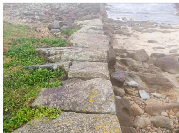
En la fotografía de la izquierda, podemos observar la coronación del muelle, con unas piedras en muy buen estado y que nos definen como era en su totalidad la parte superior del mismo y como después de los trabajos de rehabilitación, debería de quedar.
