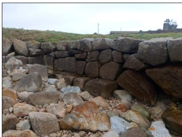
En esta parte procederemos a la sustitución de esta gran piedra que no forma parte de la estructura, desmontando esa parte del muelle y recolocando todas las piedras hasta formar las cuatro hileras iniciales.
