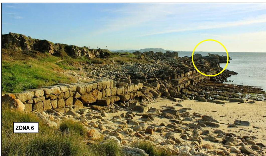
La zona 6 es la parte final del muelle, en la cual el muelle está en bastante buen estado en las dos primeras hileras de piedra pero que tiene en mal estado o carece de tercera hilera así como de la hilera de coronación.
