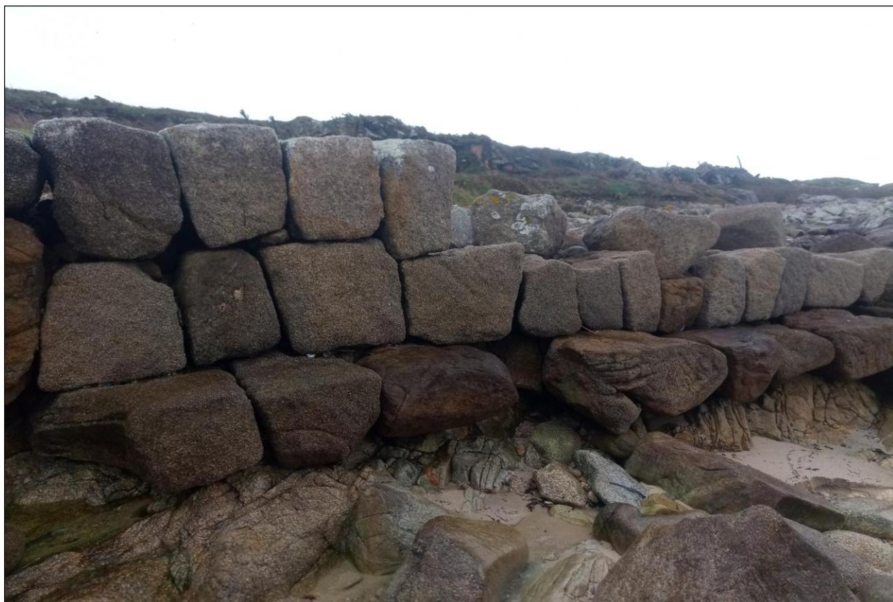
En esta zona recolocaremos la hilera superior, y cubriremos aquellos huecos existentes debido a la rotura o falta de alguna piedra que conforman el muelle.
