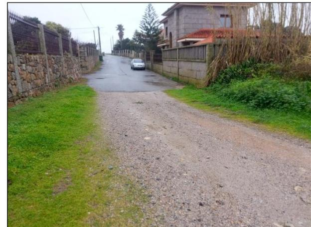
**TRAMO 3:** tiene una longitud de 32,00 m. con ancho de calzada de 3,00 metros, actualmente se encuentra pavimentado con piedra y zahorra. Además definiremos una zona en la parte superior del muelle, que se acondicionará para el acceso al mismo.
