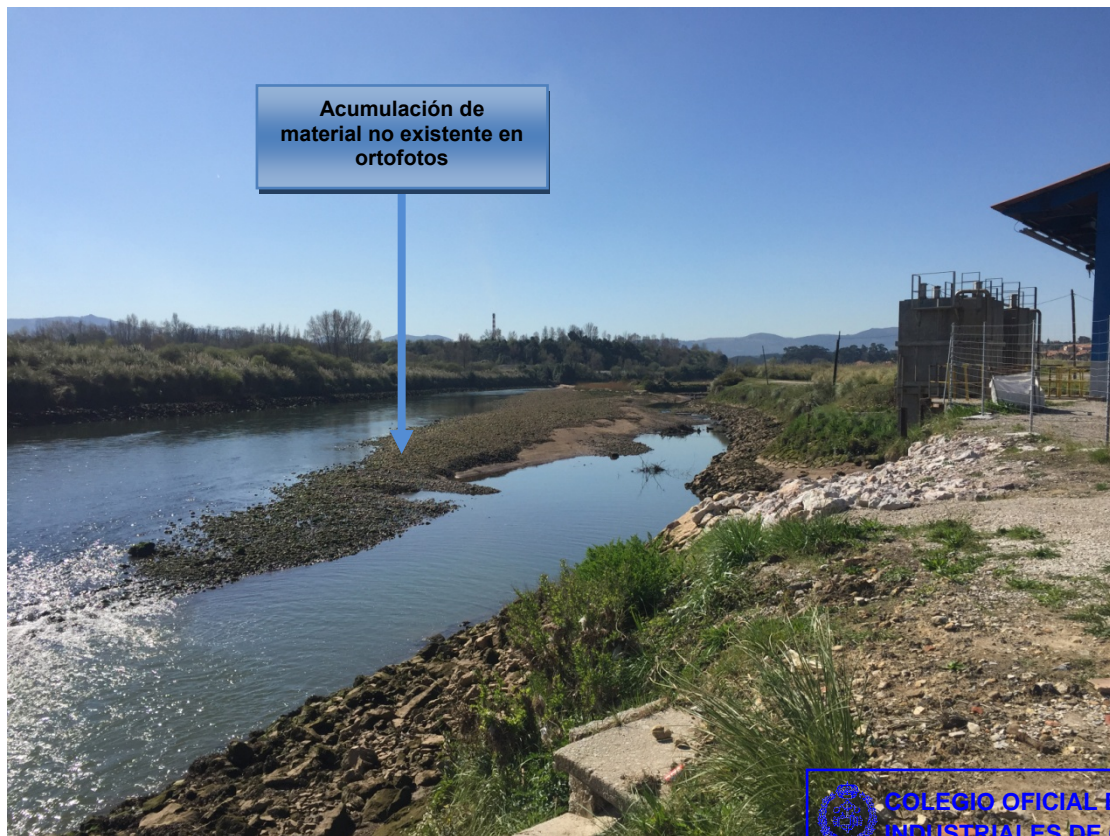
Figura 4.- Vista zona dragado Ría de San Martín.
