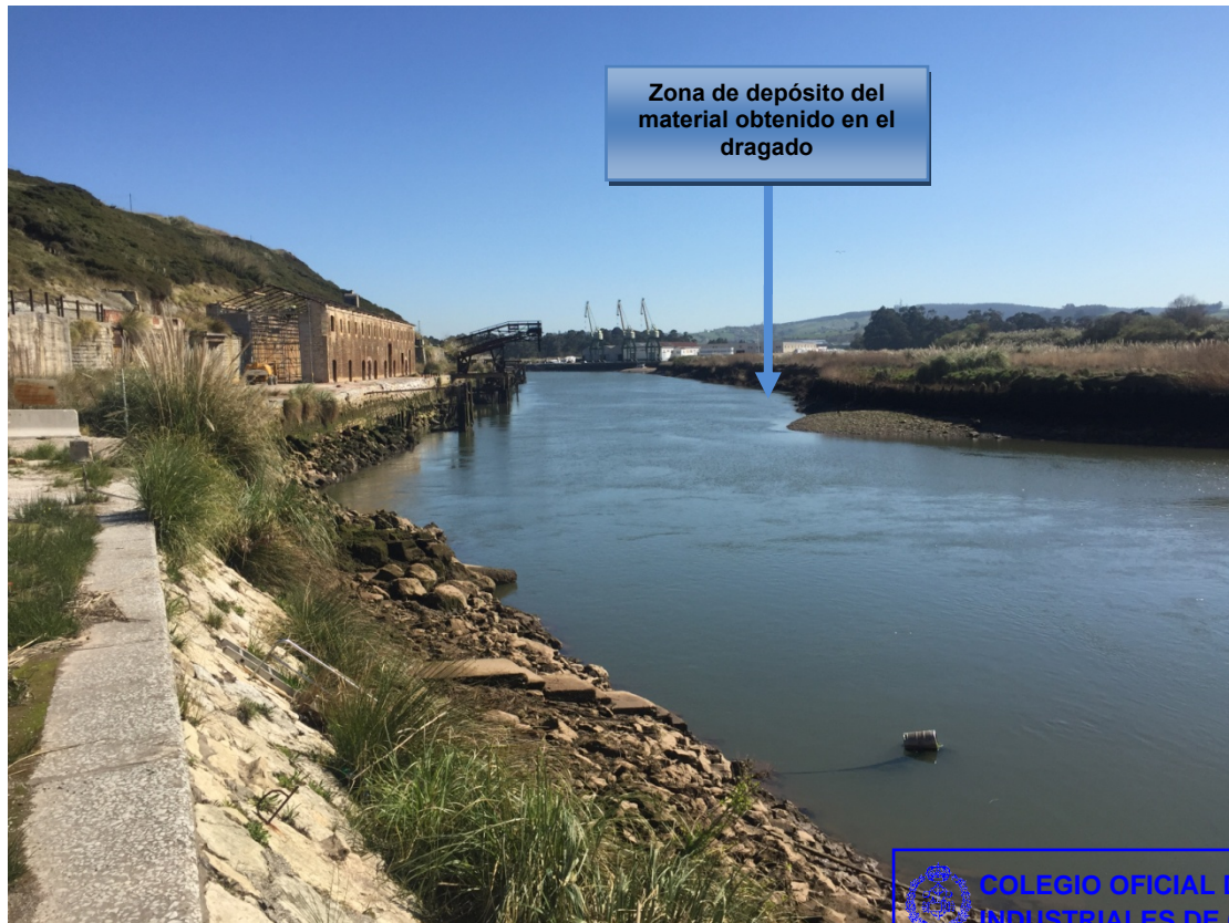
Figura 6.- Vista zona deposito material Ría de San Martín.
