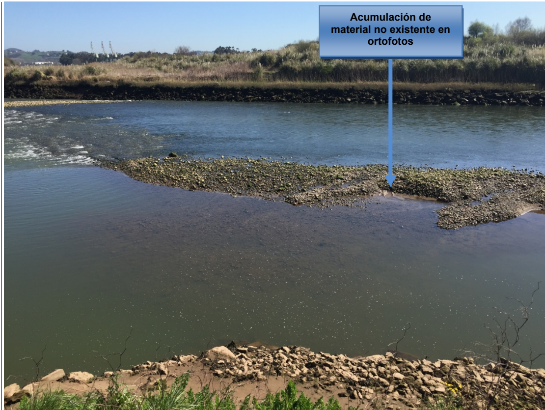
Figura 5.- Vista zona dragado Ría de San Martín.
