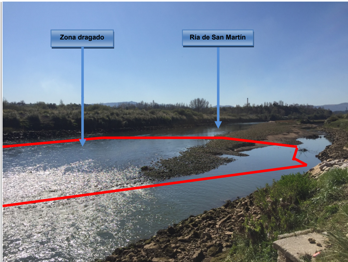
Figura 3.- Vista zona dragado Ría de San Martín.
