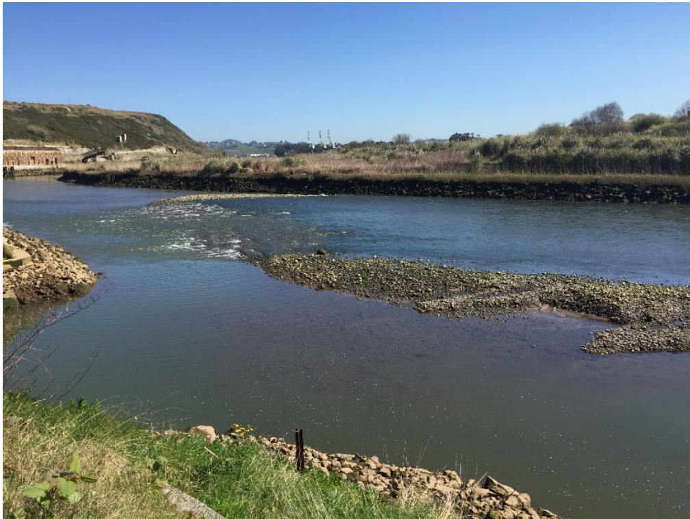
Figura 2-1.- Vista acumulación de material frente a fosos de aspiración.
