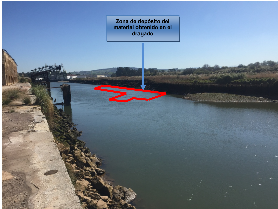
Figura 7.- Vista zona deposito material Ría de San Martín.
