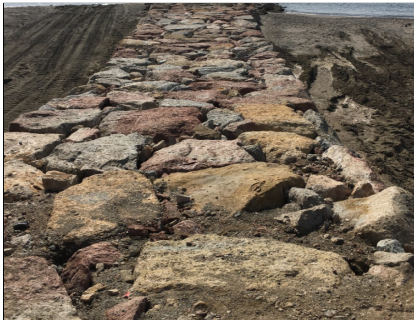
Figura 4.3 – Colocación de escollera concertada
