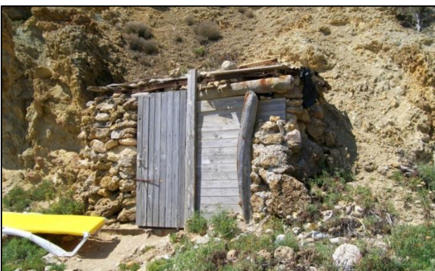
Figura 10: Vista de la caseta. Fuente: Elaboración propia
