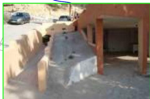
Foto 9 - Ubicacion nuevo EBAR
