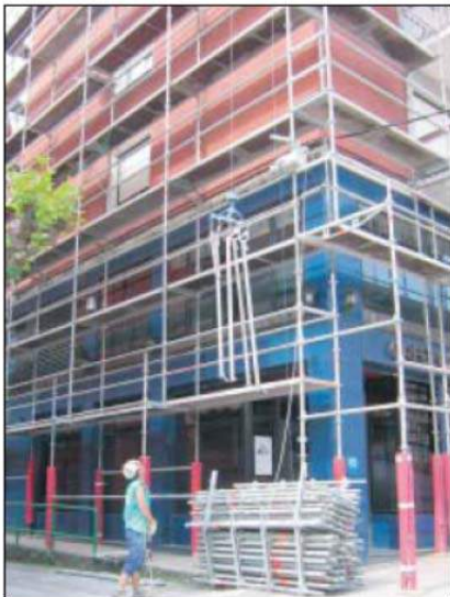
Montaje con maquinillo eléctrico
