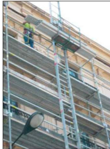
Montaje de andamio con montacargas
