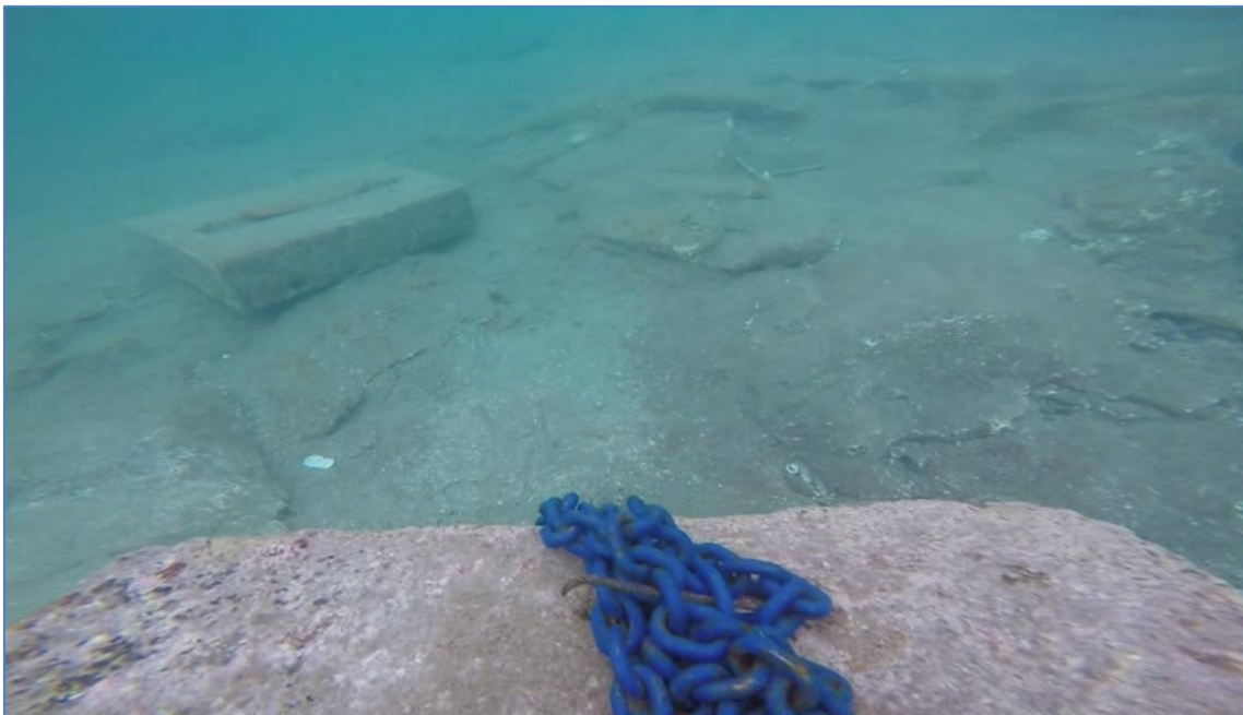
Figura 6. Lastres desplazados fuera de la traza del emisario.
