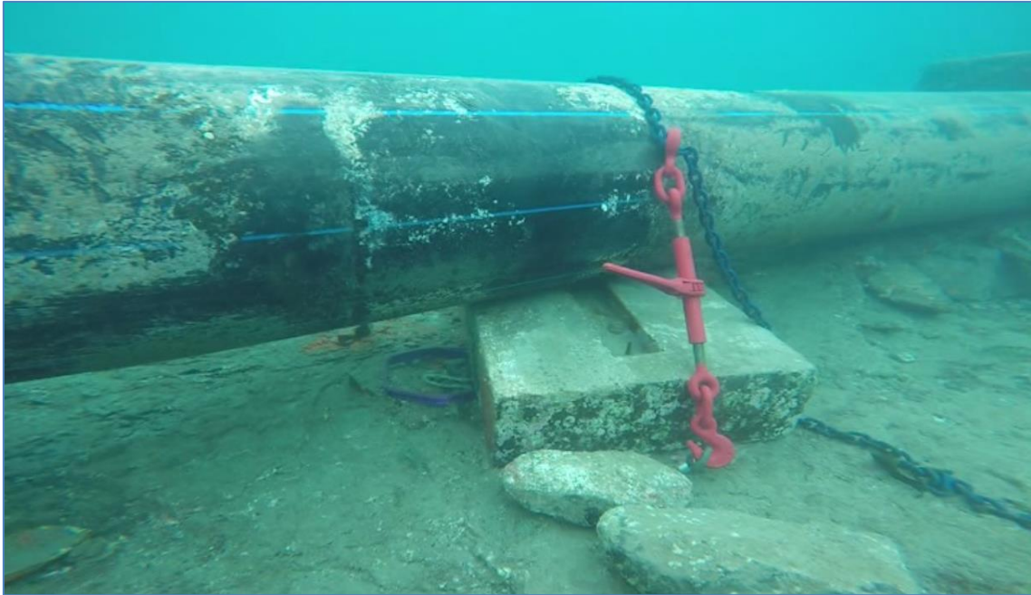
Figura 7. Lastres desplazados y anclados provisionalmente.
