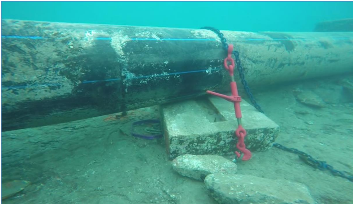
Figura 5. Lastres desplazados y anclados provisionalmente.
