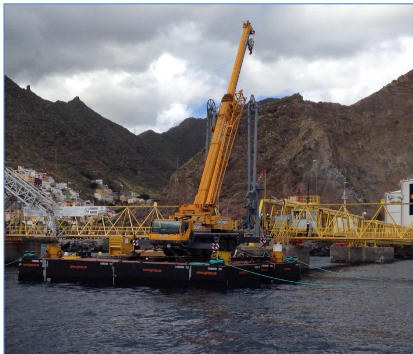
Figura 5 Pontona TEMS III con la grúa embarcada.
