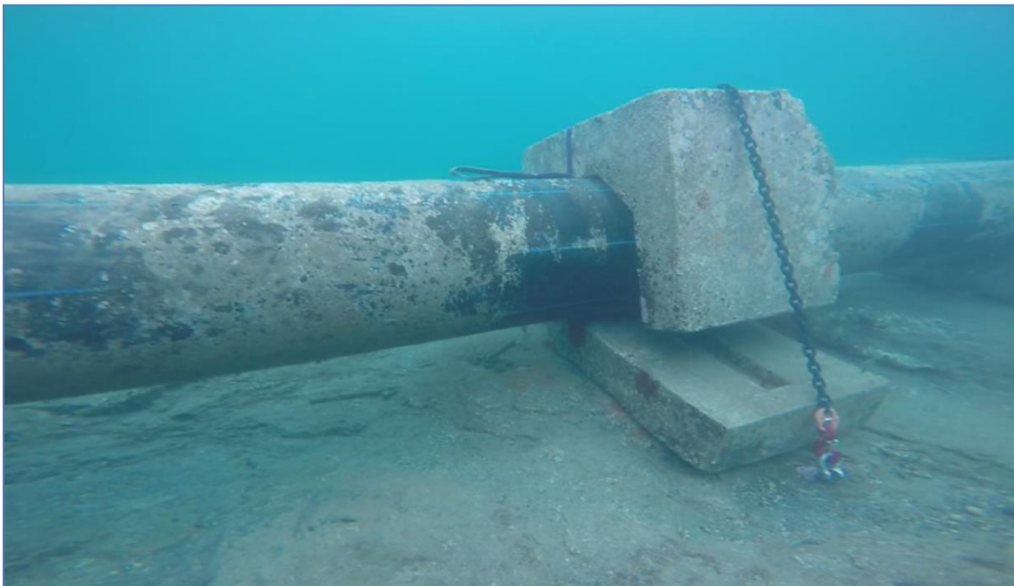
Figura 2. Lastres girados y desplazados anclados provisionalmente.
