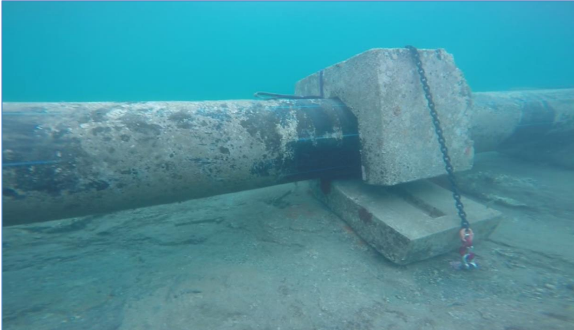
Figura 4. Lastres girados y desplazados anclados provisionalmente.
