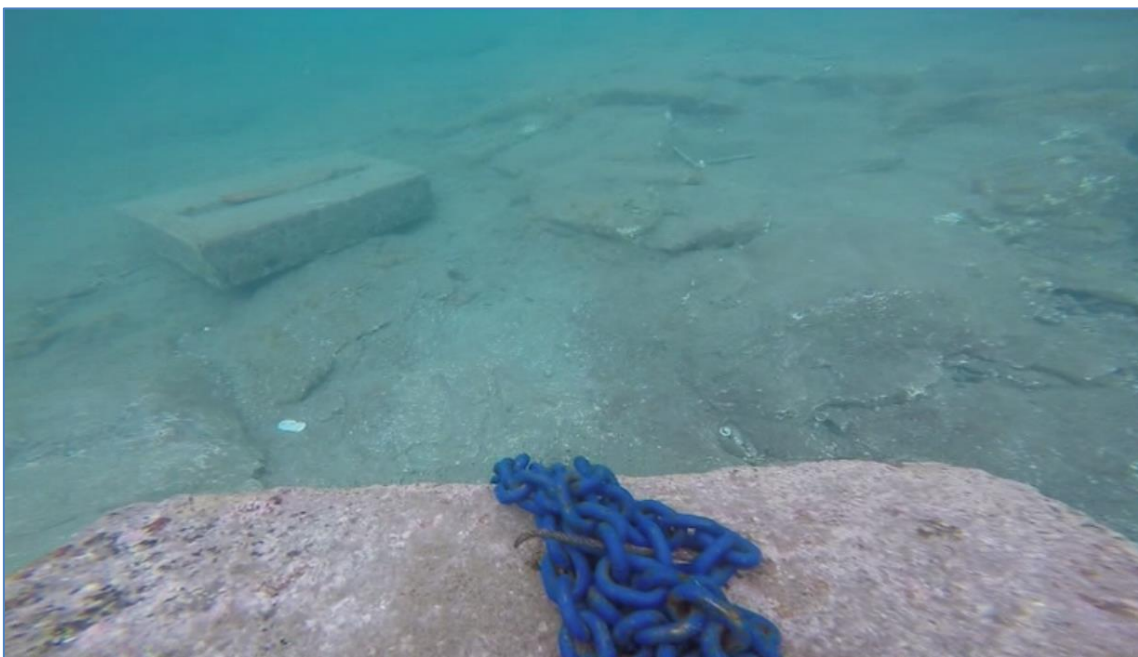
Figura 4. Lastres desplazados fuera de la traza del emisario.
