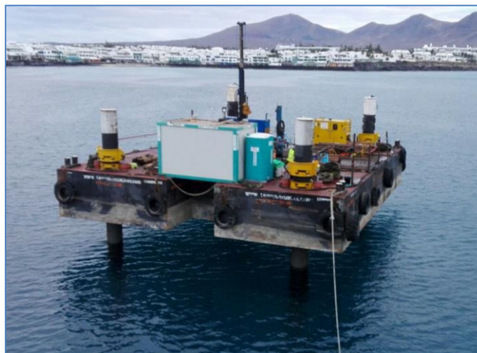
Figura 3 Pontona estabilizada TEMS III.
