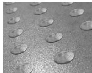
Las piezas sirven como elemento de señalización mediante contraste táctil gracias al resalte de 5 mm. Estos botones podotáctiles fabricados en acero serán de los indicados para el empleo en el exterior, fabricados en acero inoxidable AISI 304 o acero zincado.
