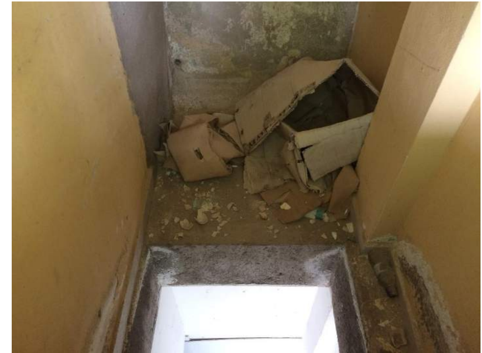
Detalle hueco montacarga. Se puede observar el tratamiento con hormigón del paramento del cantil natural en la segunda planta.
