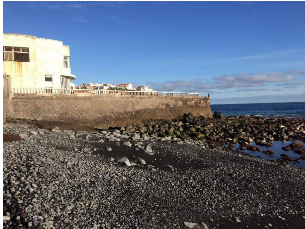
Tramo de nacimiento del muro perimetral.
