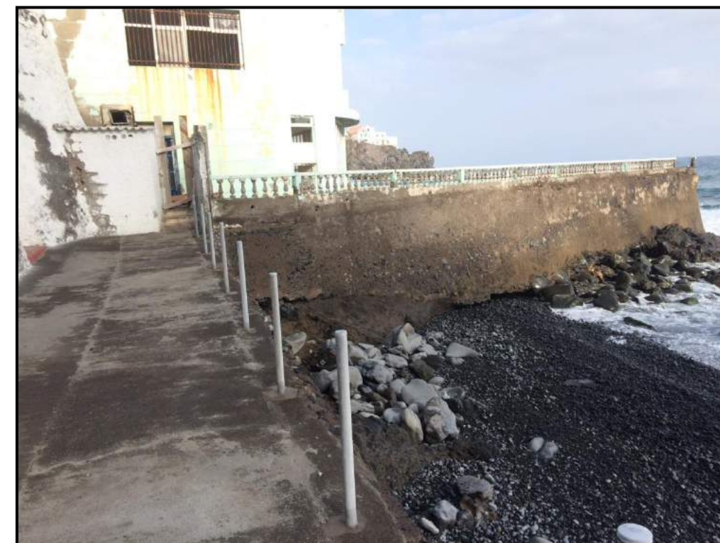
Figura 34. Acceso Este al mar. Estado actual.
