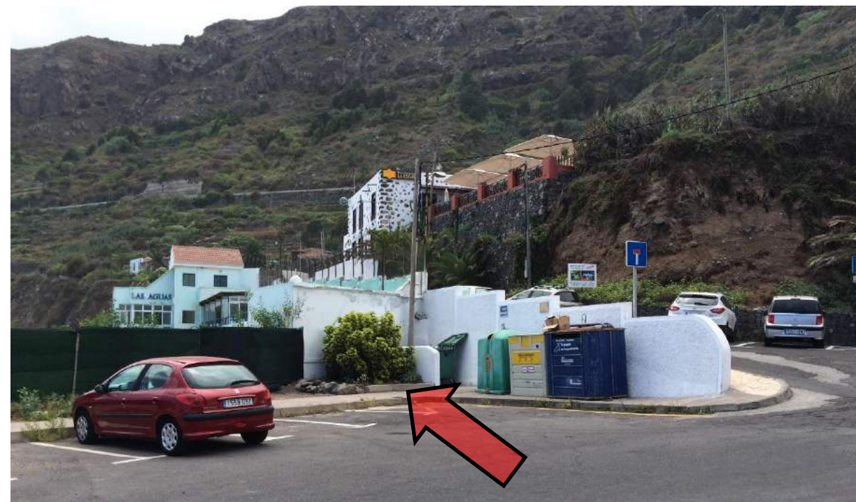
Emplazamiento soterrado de la fosa séptica existente en los alrededores de la antigua entrada principal a las piscinas.
