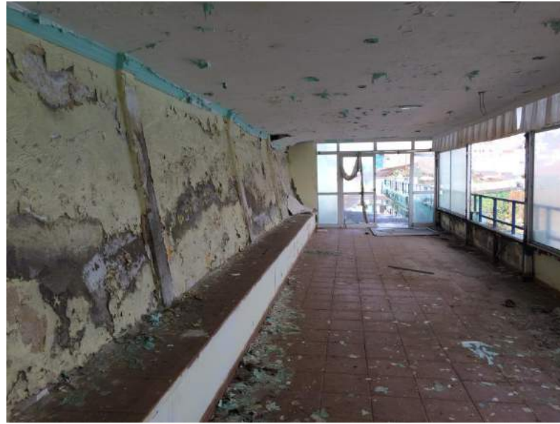
Figura 28. Muro en trasdós de edificios ( a la izquierda). La estructura del edificio se apoya en él.
