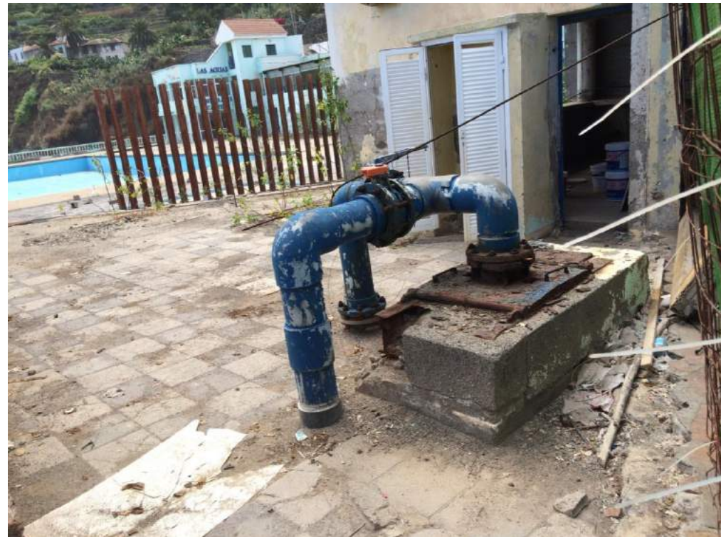
Figura 13. Concesión de la piscina municipal
