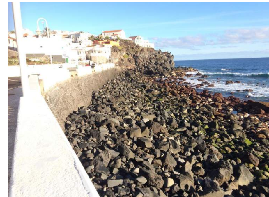
Figura 18. Acumulación de bolos en el frente marítimo del actual paseo.
