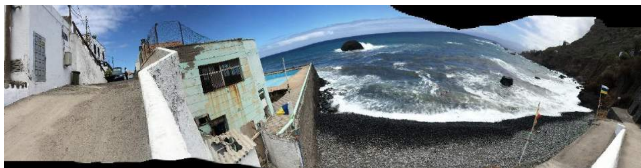
Vista desde tierra de las instalaciones. A la izquierda antiguo acceso a las piscinas, a la derecha almacenes encastrados en el muro de estabilización del acantilado.
