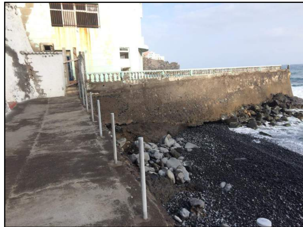
Figura 10. Acceso Este al mar. Estado actual.
