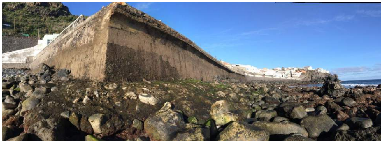
Figura 44. Panorámica general desde la zona intermareal del muro perimetral (periodo de bajamar).
