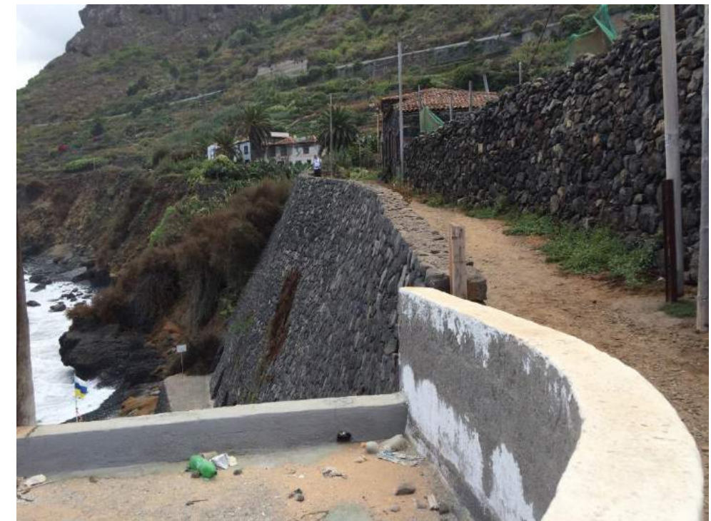
Camino de Los Alenes desde las escaleras de la calle superior. Se puede observar el muro de estabilización de los taludes de la playa de Las Aguas.
