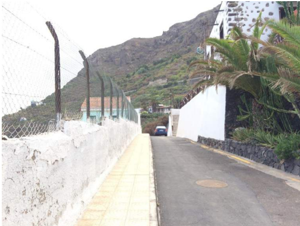
Figura 22. Parte posterior del Complejo de la piscina municipal
