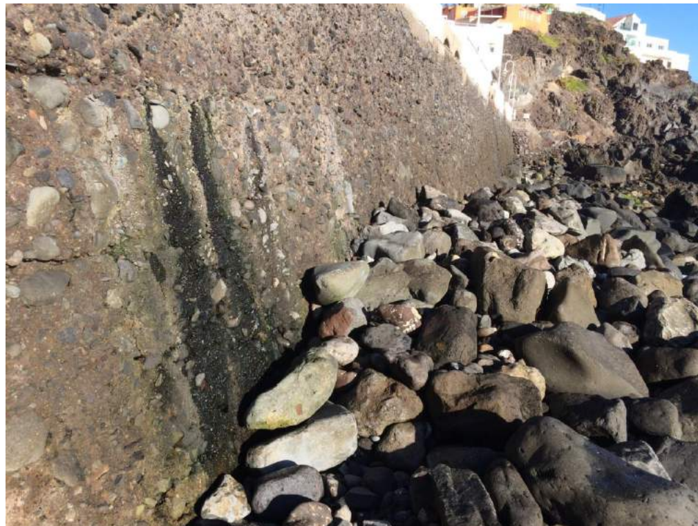
Figura 4. Paramento del muro de contención del Paseo de Las Aguas (detalle).
