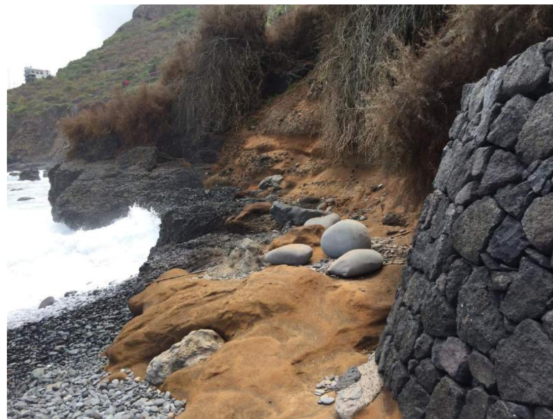
Figura 2. Detalle de pie de acantilado, en la trasera de la playa de Las Aguas.
