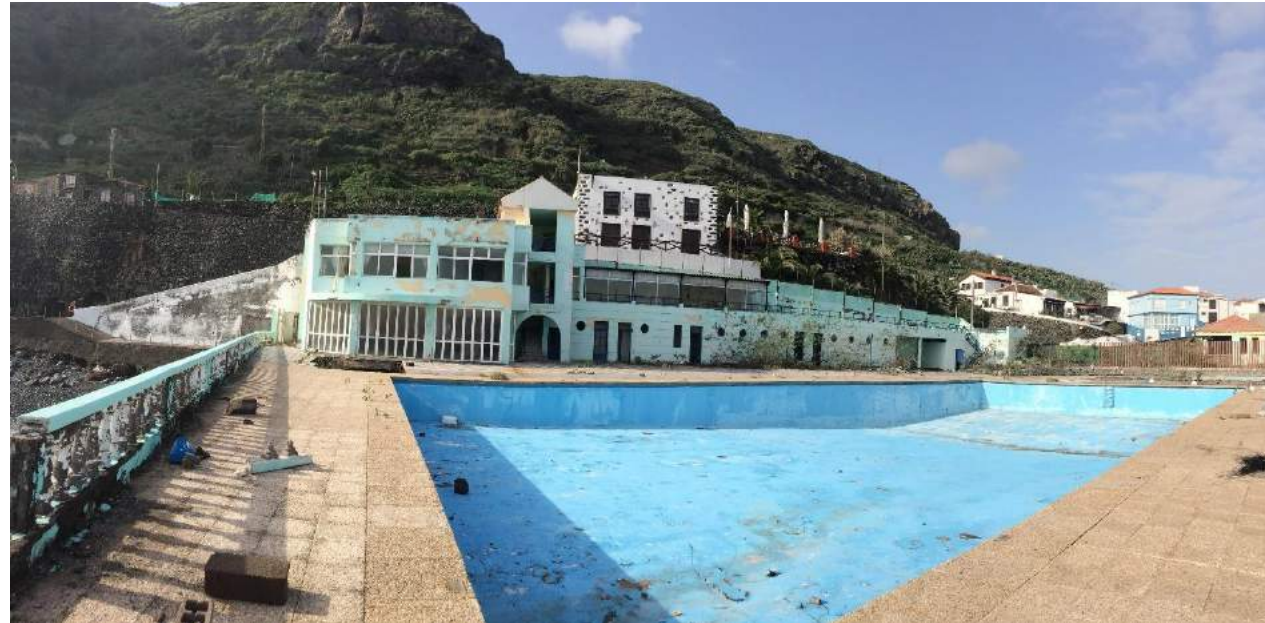
Vista general de la fachada del antiguo edificio de servicios de las piscinas que evidencia un estado ruinoso. Se puede observar la presencia en la trasera y a un nivel superior la presencia del restaurante La Escuela (edificio blanco).
