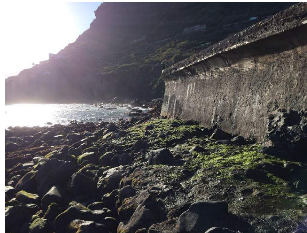
Detalle del tramo norte del muro perimetral desde el mar.
