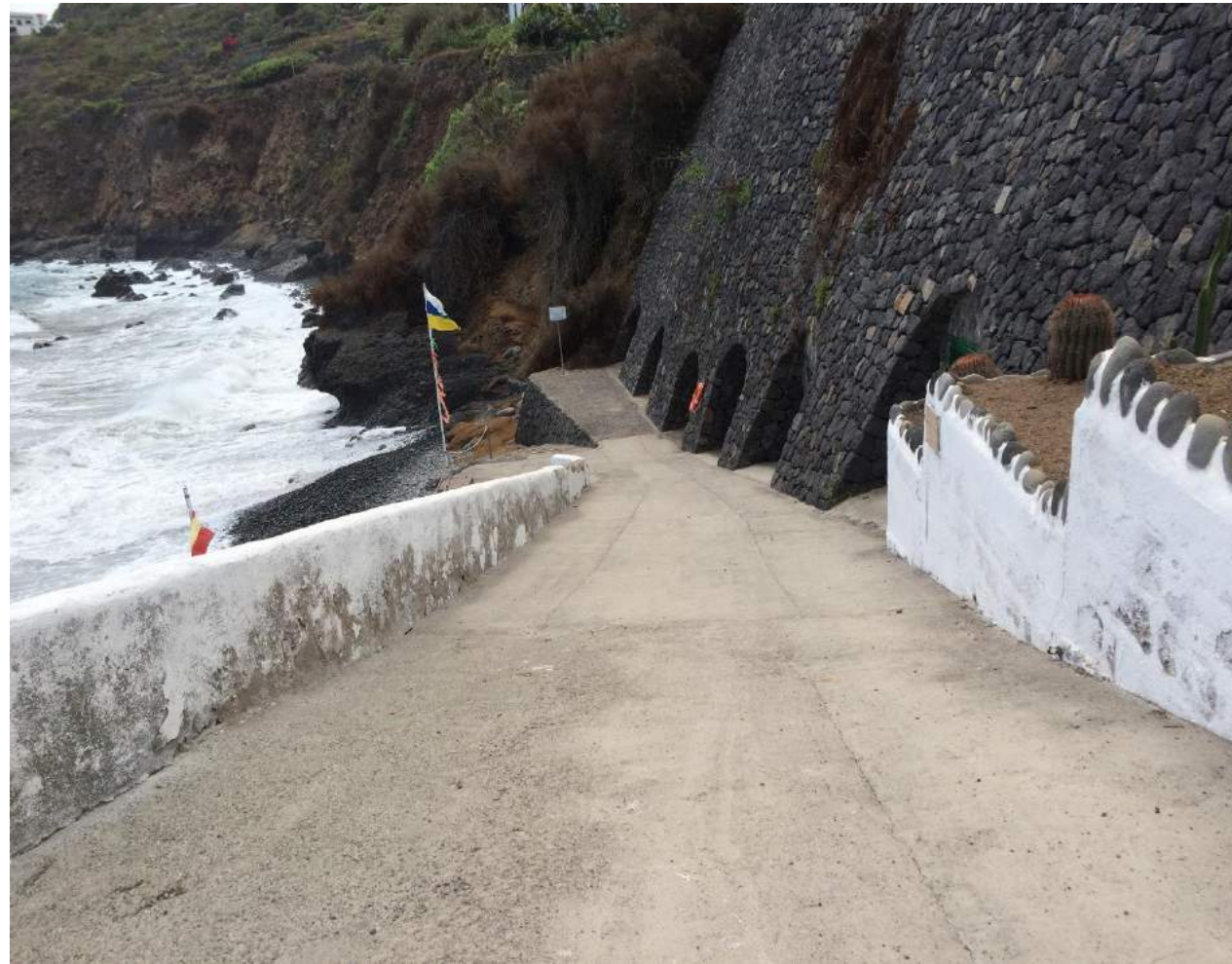
Rampa de bajada a la playa (pavimento de hormigón).
