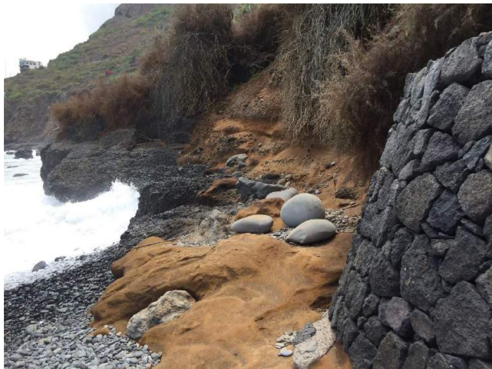
Detalle del encuentro del muro con el talud natural.
