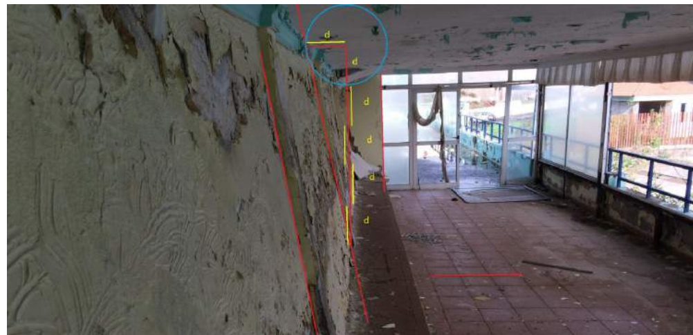
Figura 3. Talud exterior del muro en el que se apoyan los cuerpos de la edificación.
