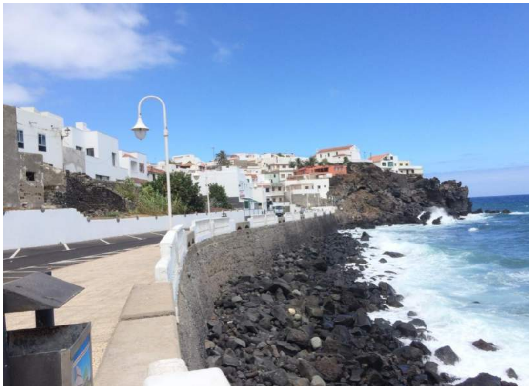
Figura 9. Vista del muro de sostenimiento
