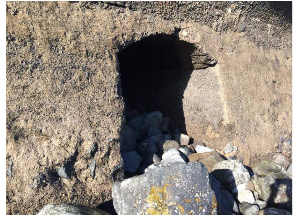
Detalle de la boca de salida.
