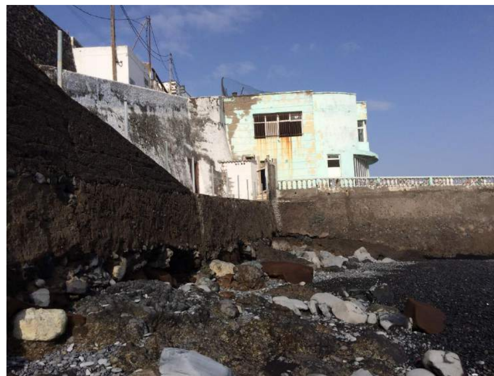
Vista desde la playa del antiguo acceso a las piscinas.
