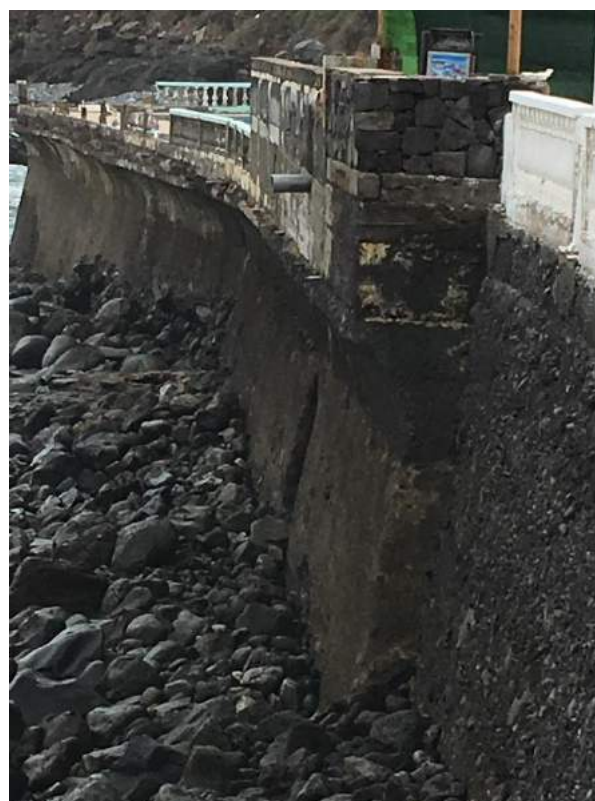
Detalle del tramo norte del muro perimetral desde el paseo litoral.
