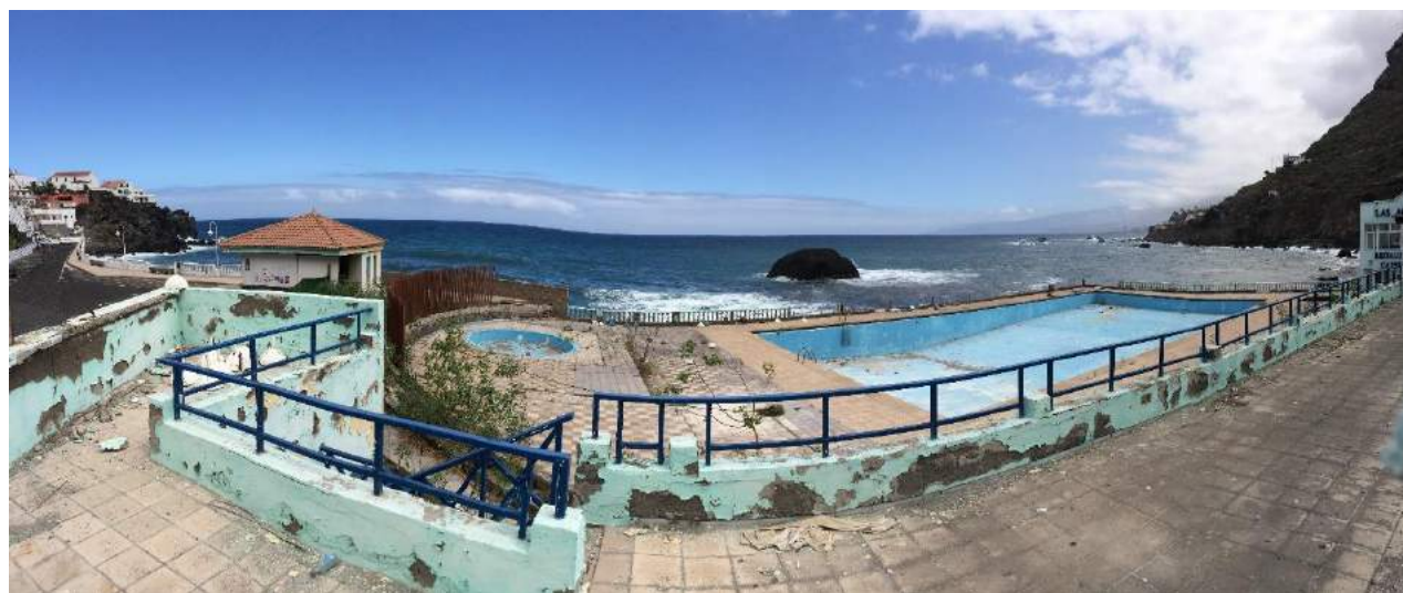
Antiguo acceso desde el Paseo Adolfo Suárez al edificio. Vista general.
