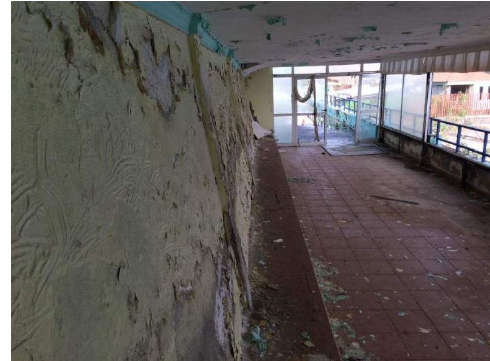
Figura 8. Vista parcial del interior de los edificios.
