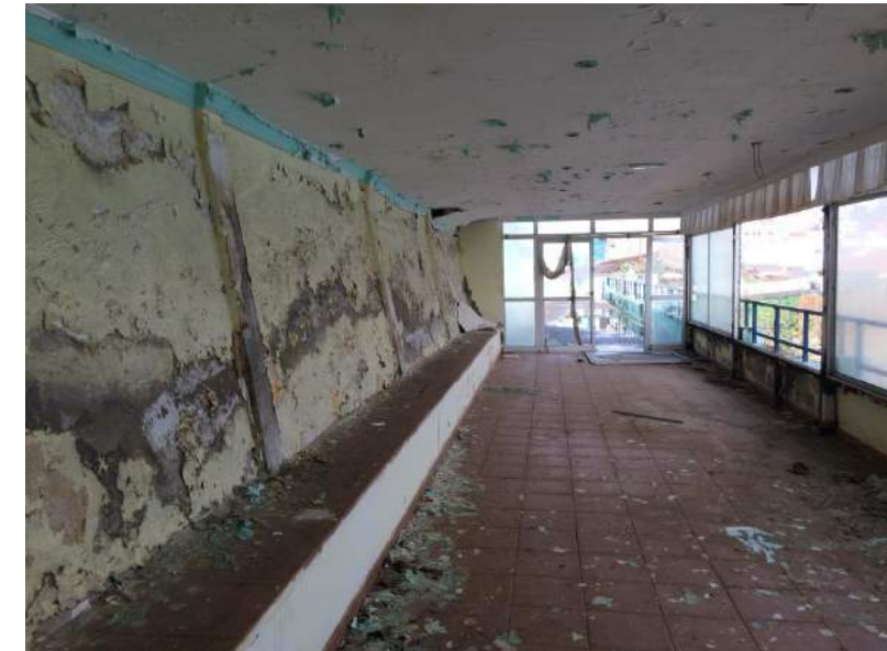
Figura 5. Muro en trasdós de edificios (a la izquierda). La estructura del edificio se apoya en él.
