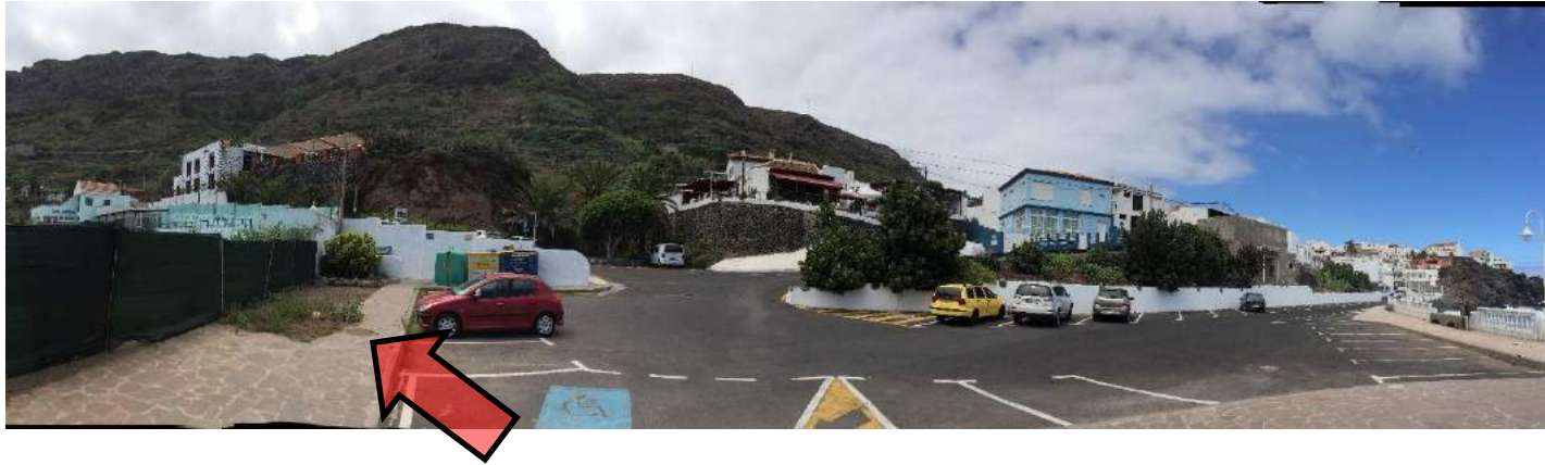
Pozo de registro de la red de saneamiento actual más próximo a la fosa séptica.
