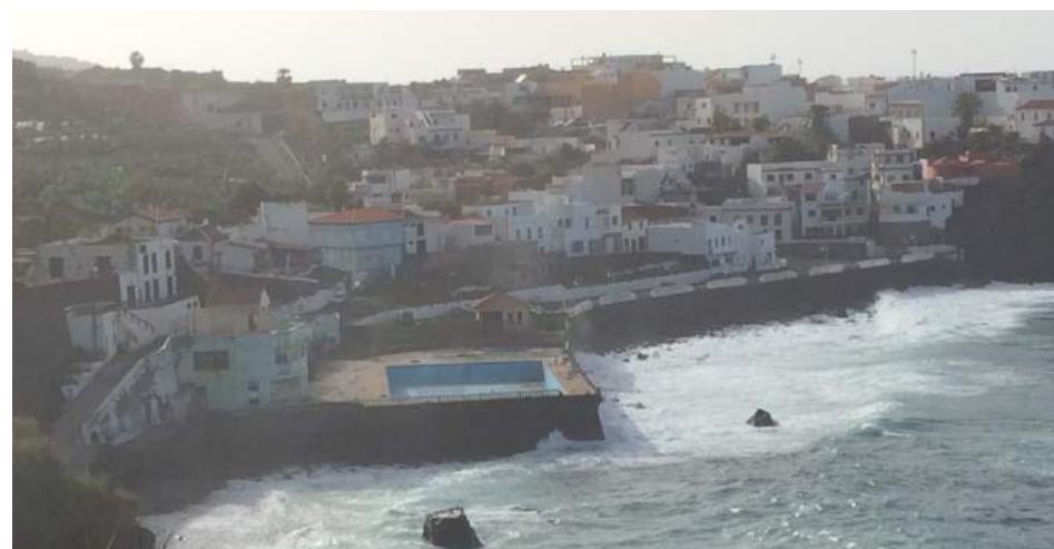
Figura 39. Vista general de la zona de obras. En primer término, las piscinas fuera de servicio, al fondo el Paseo Adolfo Suárez.
