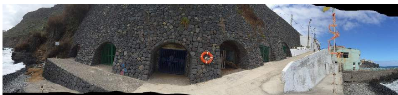
Vista frontal de las instalaciones. A la derecha antiguo acceso a las piscinas, a la izquierda almacenes encastrados en el muro.
