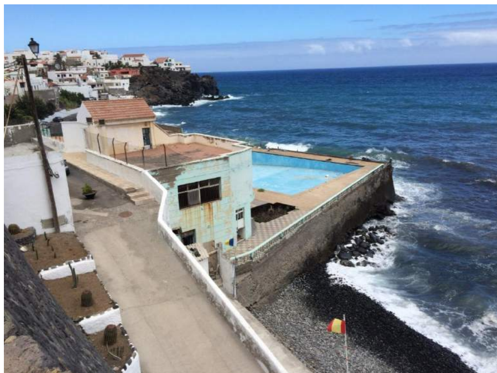
Figura 25. Acceso a la playa y complejo de la piscina municipal
