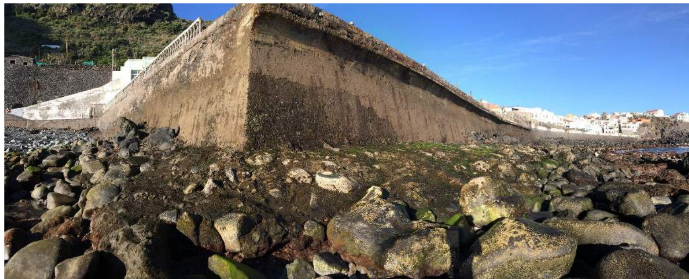
Vista general del muro perimetral.
