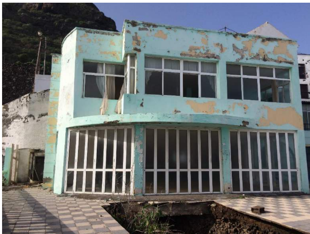
Detalle fachada y plataforma de solárium exterior.
