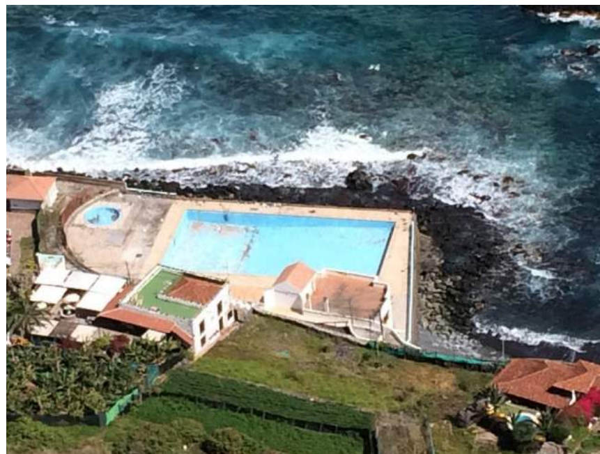
Aproximación aérea a las instalaciones a demoler.
