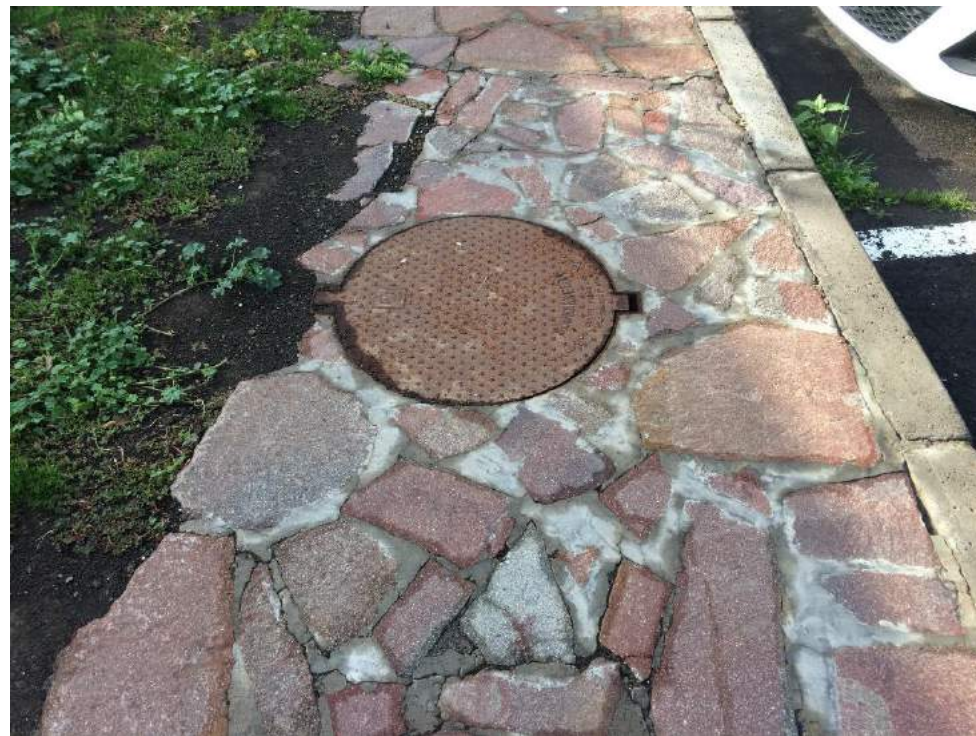
Detalle del registro de la red de saneamiento próximo a la fosa séptica.
