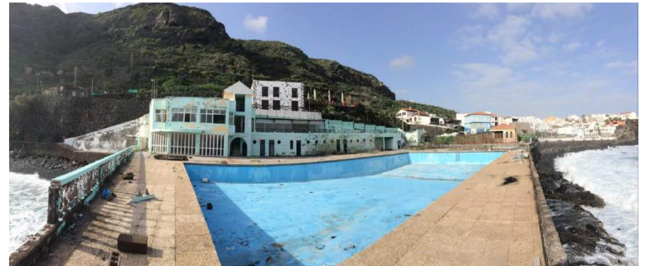
Figura 5. Vista general de las piscinas abandonadas.
