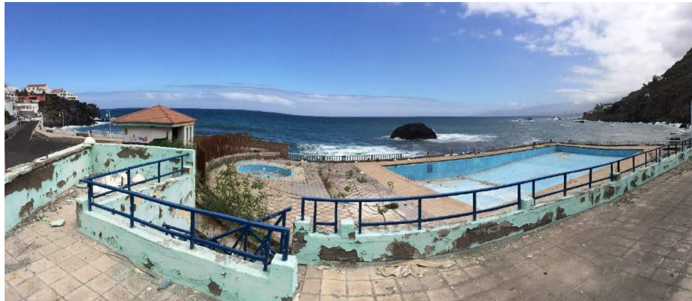
Vista general de las piscinas.
