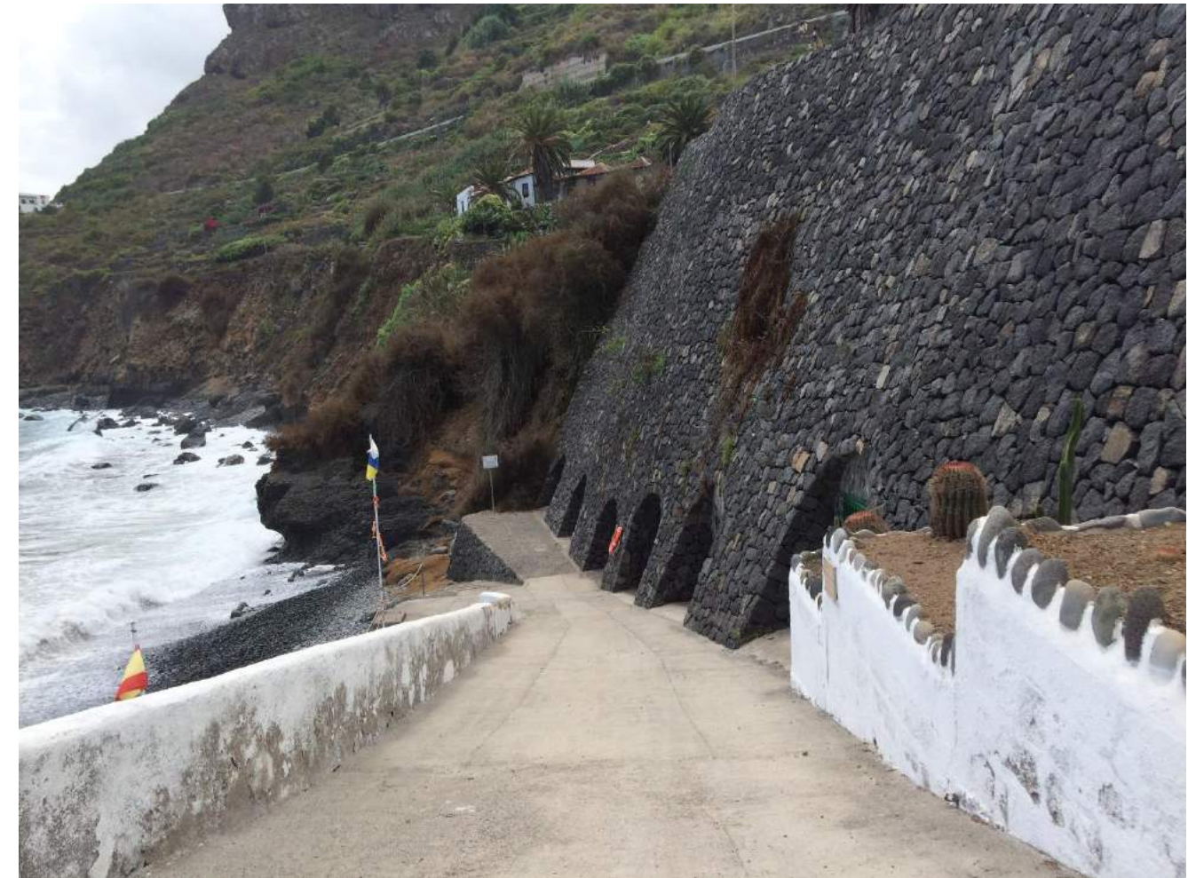
Vista general del muro de estabilización del talud en la trasera de la playa.
