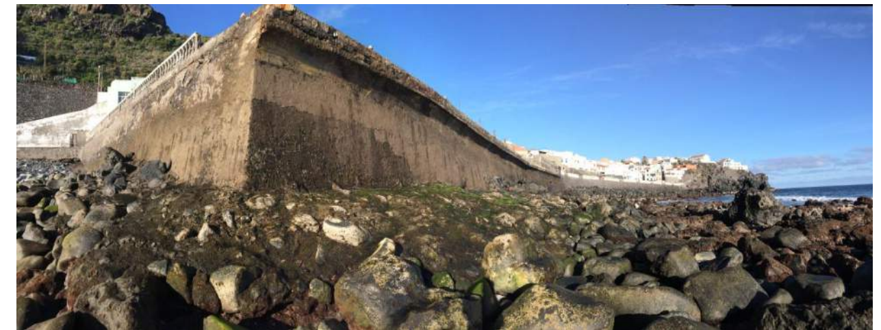
Figura 54. Panorámica general desde la zona intermareal del muro perimetral (periodo de bajamar).
