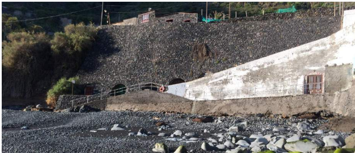
Figura 1. Acabado del muro en la rampa del actual acceso a la playa.
