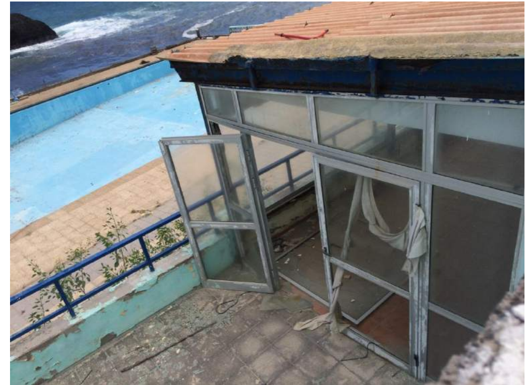
Figura 23. Complejo de la piscina municipal
