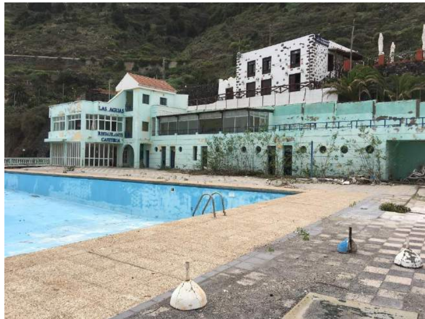
Vista general de la fachada (aproximación).
