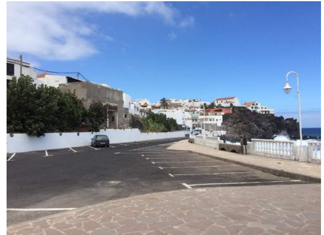
Figura 15. Vista del actual paseo
