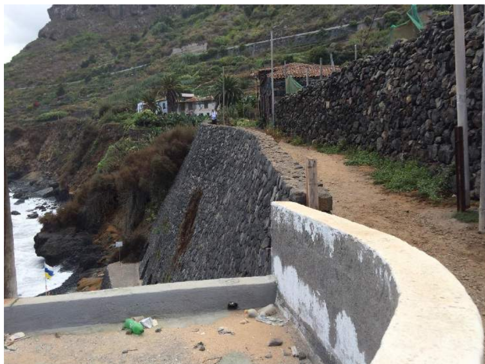
Coronación del muro de estabilización en el Camino de Los Alenes
