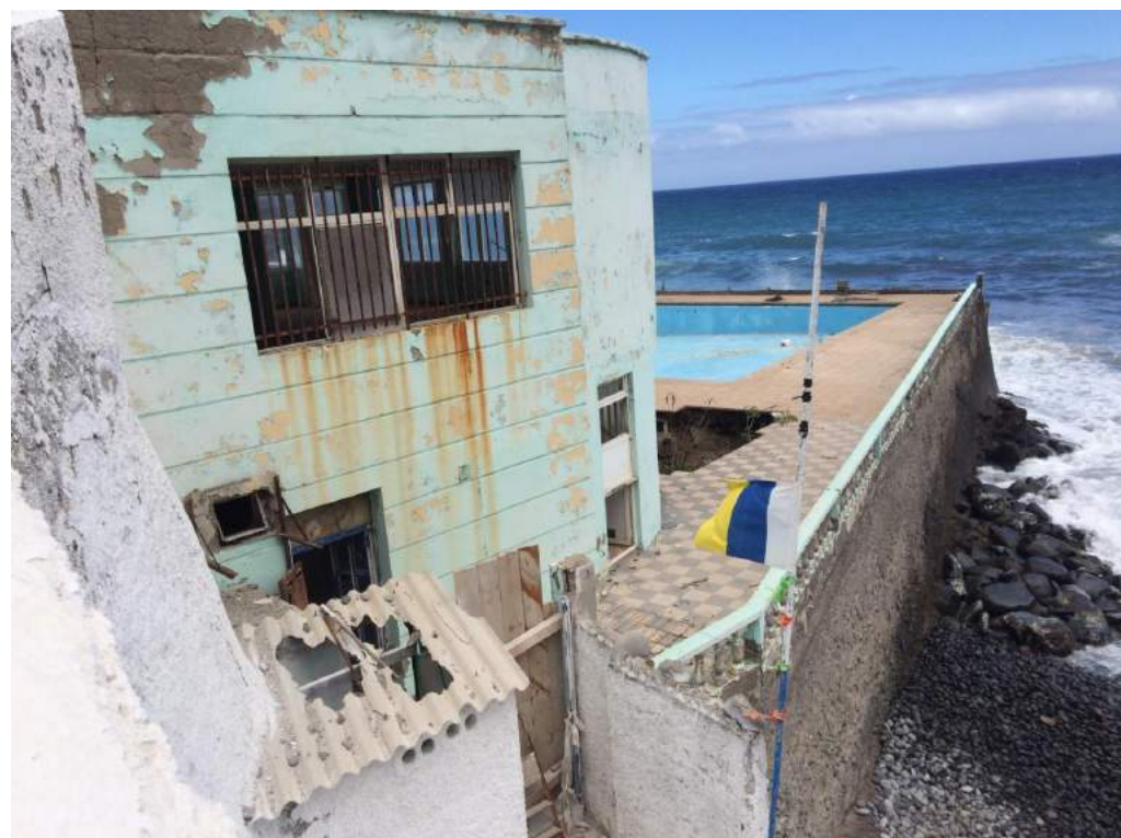
Figura 26. Vista posterior del restaurante Las Aguas
