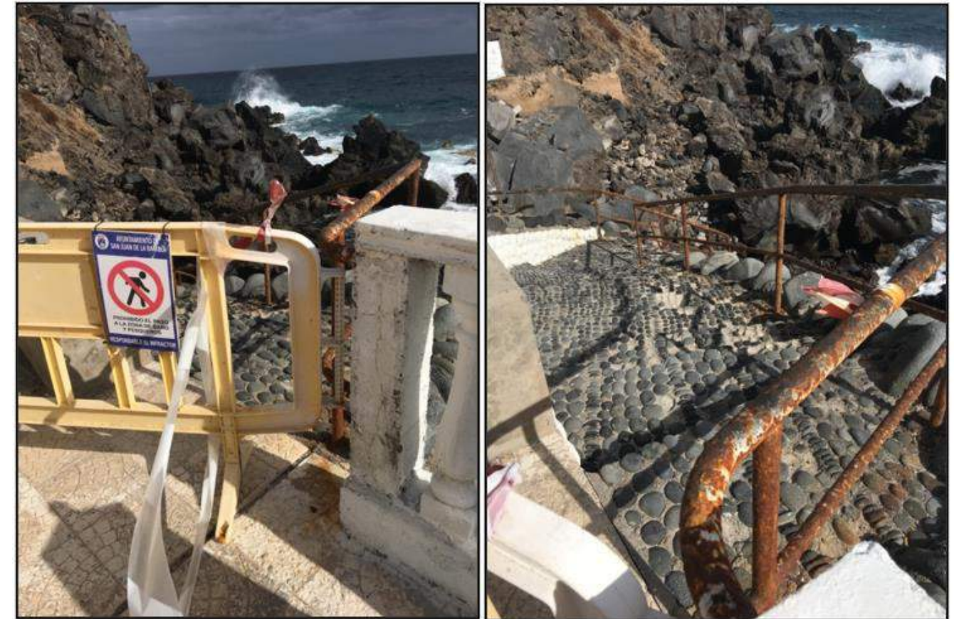
Figura 9. Acceso Oeste al mar. Estado actual.
