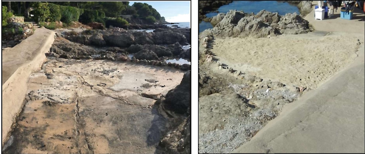
Figura 11 Plataforma de Hormigón
