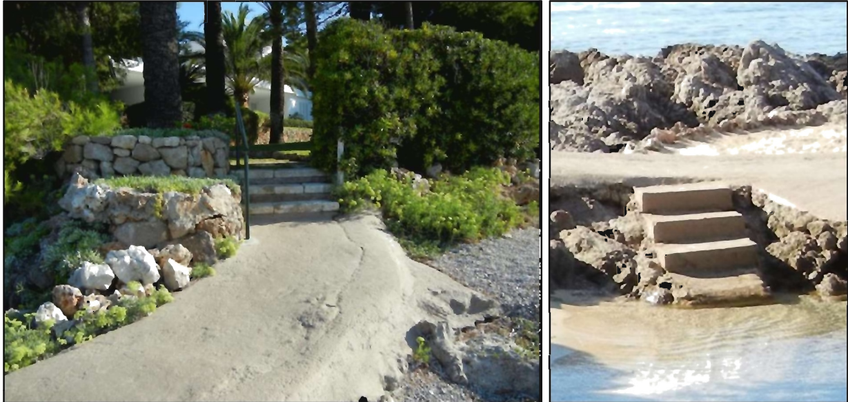
Figura 9 Detalle del sendero y peldaños
