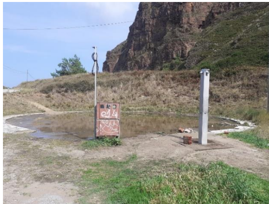
Solera de hormigón de antigua concesión
