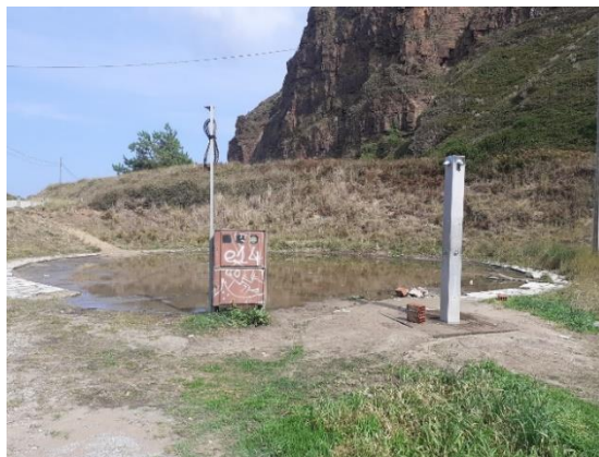
Solera de hormigón de antigua concesión
