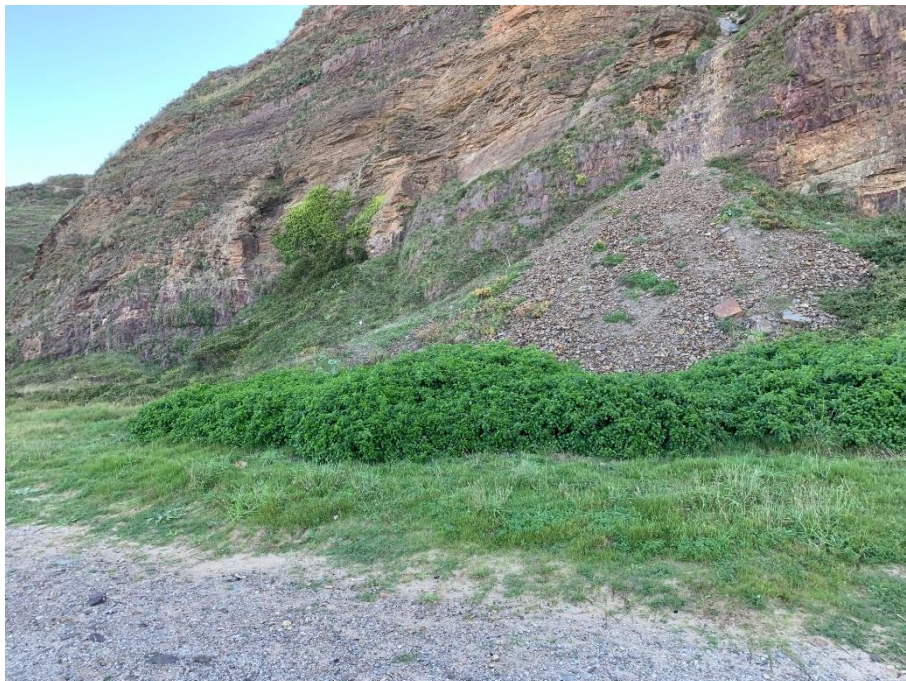
Vista de los desprendimientos de la parte oriental del acantilado
