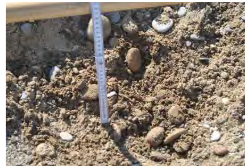
Ilustración 4. Detalle de la cata 2
