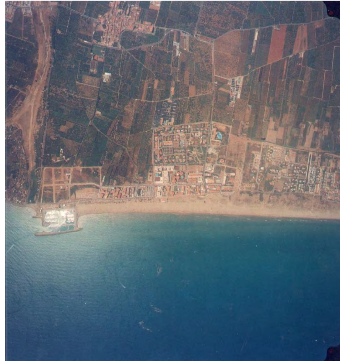
Figura 13. Situación del tramo de proyecto en el año 1.994. Playa de Canet
