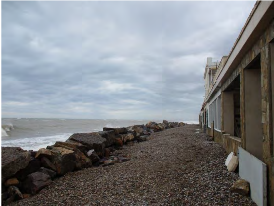
Figura 29. Es collera de protecció en las casa de Queralt – 13/09/2.019
