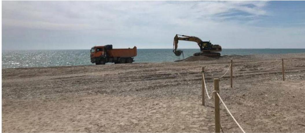
Figura 25. Carga de camión con gravas en la playa de Almadá. Fuente: Demarcación de Costas en Valencia, 2020.
