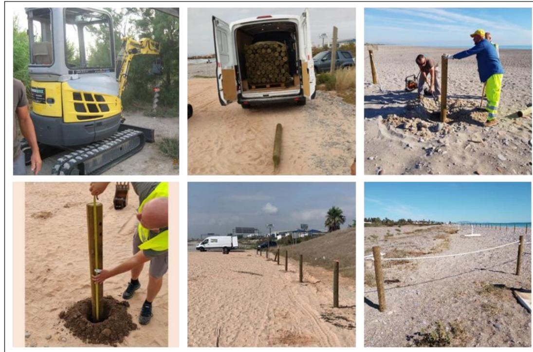
Figura 9. Pilotes de madera para cerramiento.
