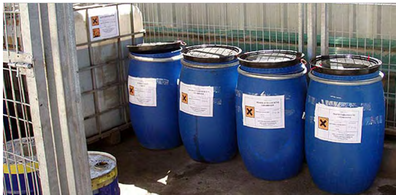
Figura 2. Ejemplo de separación de residuos peligrosos en obra
