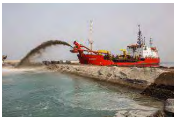
Figura 7. Método de descarga tipo rainbow
