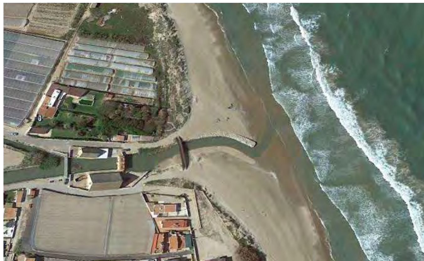
Figura 1. Actual estado de los espigones de la Gola del Rey.
